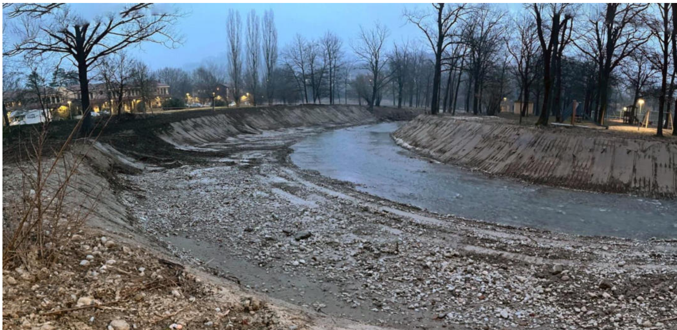
Lavori eseguiti fra 12/2024 e 02/2025 di allargamento sezione alveo e ripristino sponde su sinistra e destra idraulica
